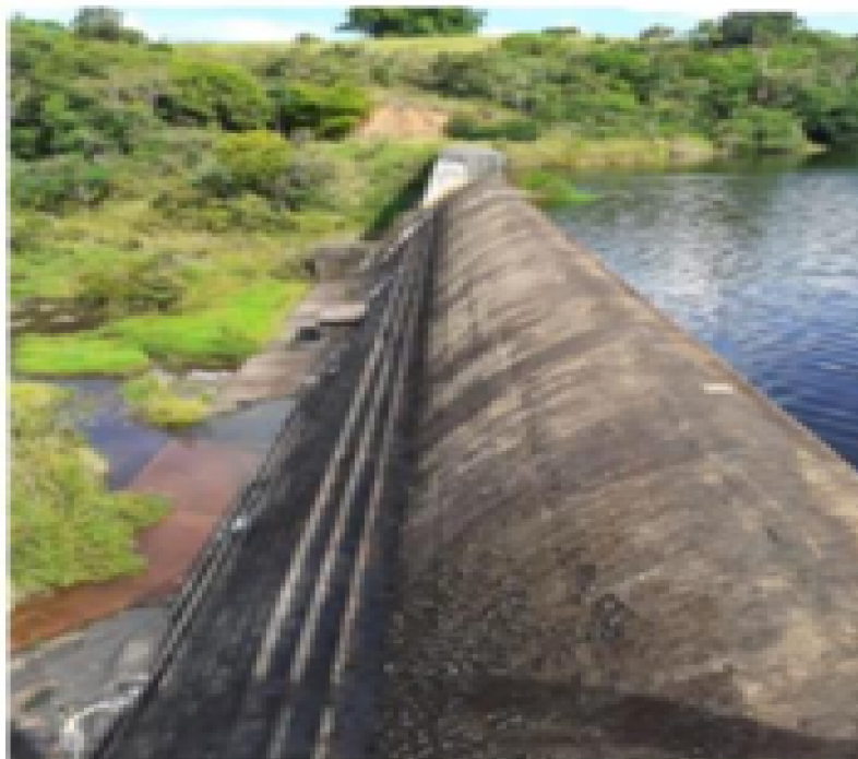
Figura 1 - Barragem do Rio da Dona
