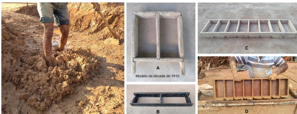
Figura 02 – Preparo da massa argilosa (argila) para produção de tijolos maciços e tipos de fôrmas.
