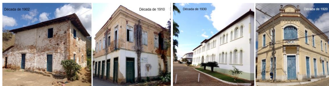
Figura 5 – Conjunto de edificações do início do Séc. XX concebidas com tijolos maciços.
