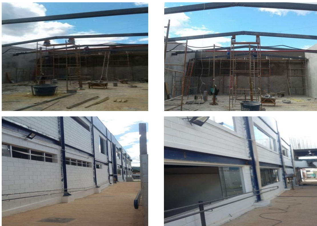
Figura 1 – Obra de expansão das Faculdades Prominas em Montes Claros - MG
