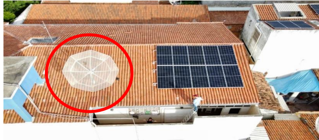
Figura 6 - Vista superior do sistema FV 1
