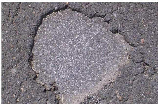
Figura 5 – Exemplo de manifestação Classe 1: área localizada de fundo plano. Fonte: PavementInteractive.org.
