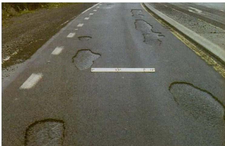
Figura 6 – Exemplo de manifestação Classe 2: múltiplas áreas afetadas. Fonte: lgam.wikidot.com/delamination.
