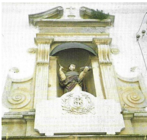
Figura 4 - Pormenor da fachada principal. . Paula, Rui M; Paula, Frederico. Faro, evolução urbana e património , Câmara Municipal de Faro, Faro, 1993. p. 267
