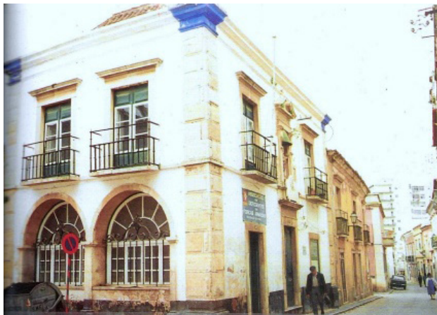
Figura 3 - Fachada da Casa do Compromisso, Faro. Paula, Rui M; Paula, Frederico. Faro, evolução urbana e património , Câmara Municipal de Faro, Faro, 1993. p. 267
