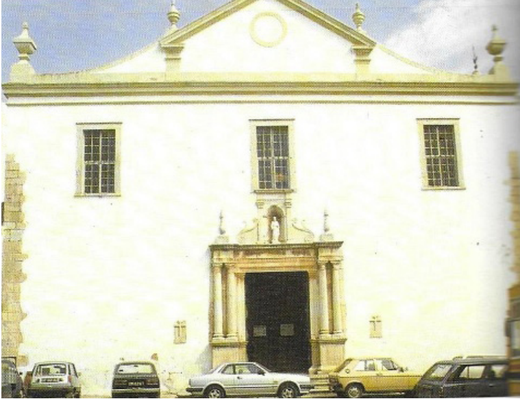
Figura 2 - Fachada principal da Igreja de São Pedro. Paula, Rui M; Paula, Frederico. Faro, evolução urbana e património, Câmara Municipal de Faro, Faro, 1993. p. 234
