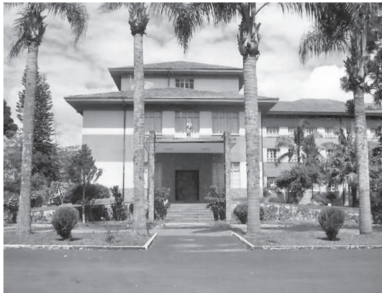
Figura 01 – Fachada do Seminário Verbo Divino.
