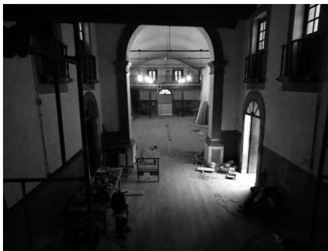
Imagem 7: Interior da igreja de S. Sebastião de Porto de Cima
