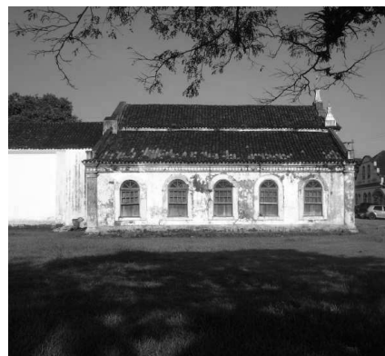
Imagem 4: Sacristia da Igreja de São Sebastião de Porto de Cima/Paraná
