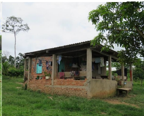
Figura 9 – Casa em alvenaria
