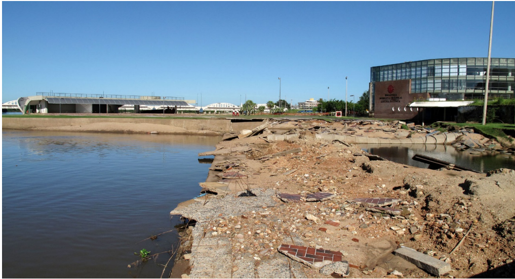
Figura 9: Visão da destruição deixada pós enchente de 2009. Ao fundo, à esquerda, o Museu MADI. À direita, a Biblioteca Pública Municipal Lustosa da Costa
