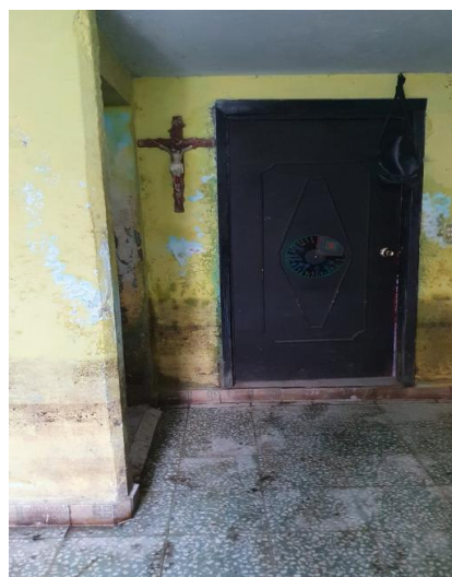
Figura 3 - Daños por inundaciones en casa asentada en antigua laguna.
