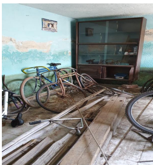
Figura 3 - Daños por inundaciones en casa asentada en antigua laguna.
