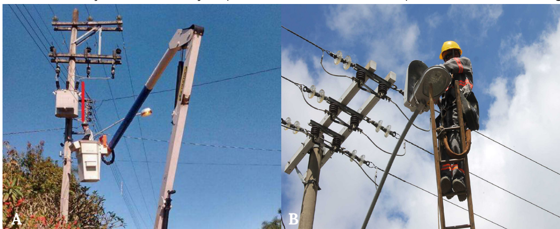
Figura 4 - Manutenção da iluminação pública com acesso a ZC para alta tensão energizada.
