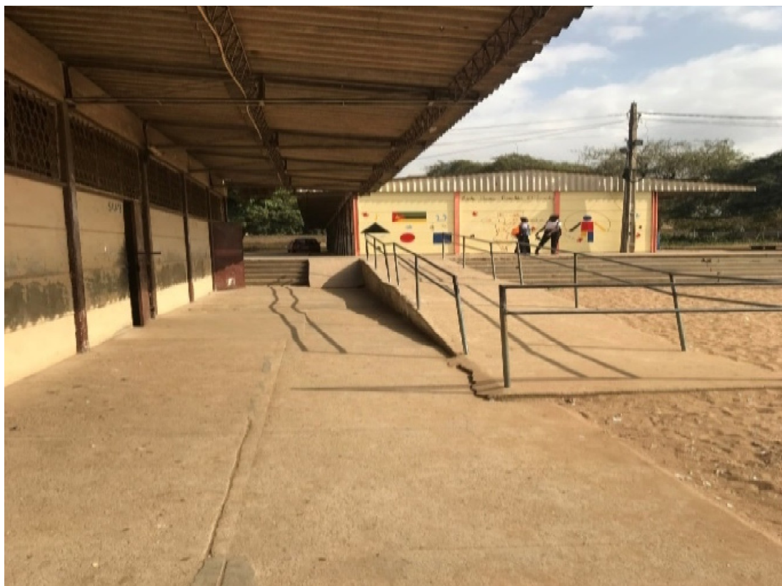
Figura 3 - Corredor de comunicação com rampa e corrimão em pé. Fonte: O autor do trabalho (2019)
