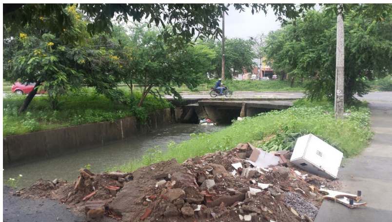
Figura 4: Margem direita do canal da Av. G.
