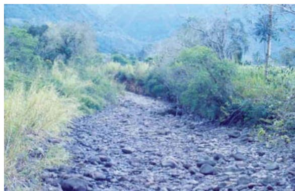
Figura 5 – Leito do rio Amola Faca no sopé das encostas da Serra Geral entulhado de sedimentos clásticos de diferentes tamanhos. Visão para montante. Notar a falta de fluxo na superfície, porém este ocorre abaixo dos clastos e aflora mais a jusante. A foto foi tirada próximo do local onde foi realizada a seção transversal 03. Observar a margem abrupta à direita e ao fundo da foto. Foto: Gilberto Tonetto, set. 2006.
