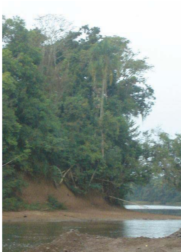
Figura 18 - Rio Amola Faca próximo da confluência com o rio da Pedra. Visão para jusante. Observar erosão da margem e queda de árvores a poucos metros a jusante do sítio de extração de clastos. descrito na Figura 21.
