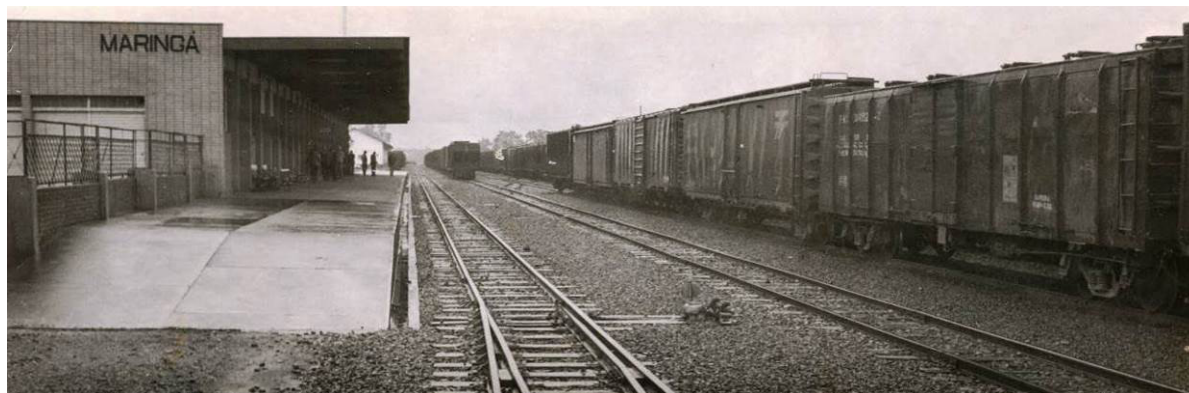
Figura 3. Estação ferroviária de Maringá na década de 1960.
