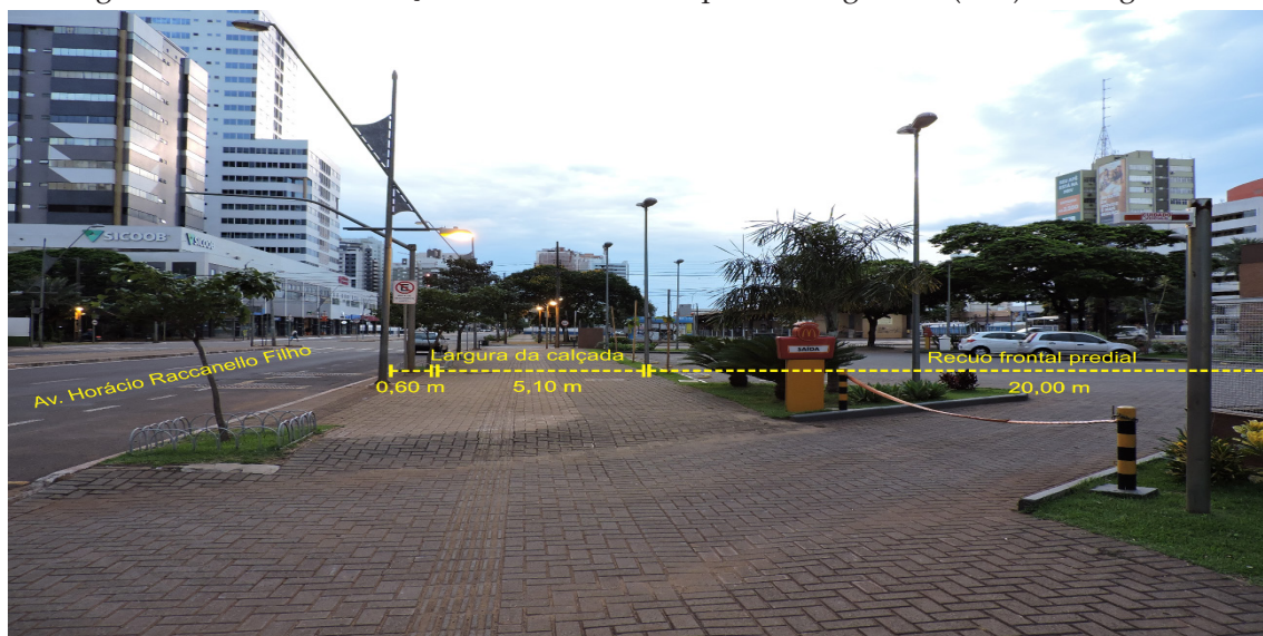
Figura 18. Vista de edificação com recuo frontal predial na gleba A (ZE1), Maringá, PR.
