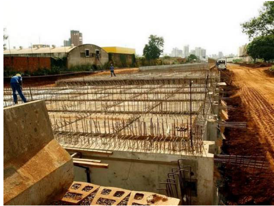
Figura 10. Vista das obras do viaduto da Av. Tuiuti (2007).
