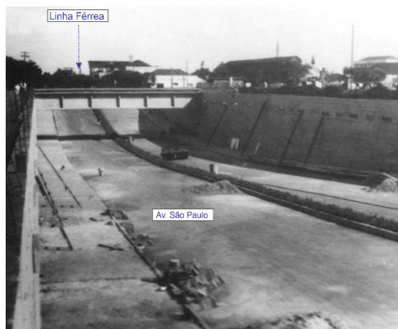
Figura 4. Obras de implantação do viaduto do Café na década de 1960.
