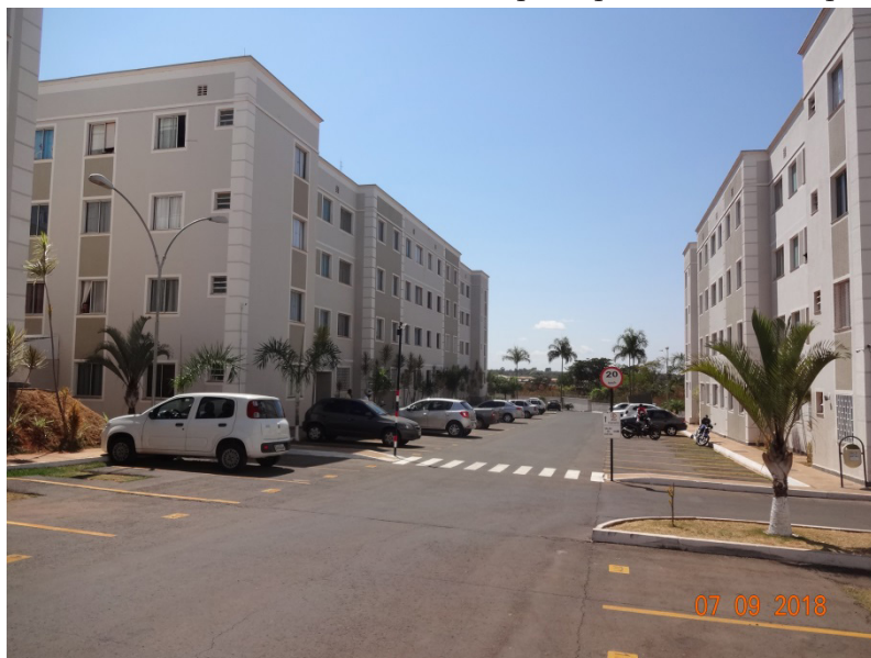
Figura 6. Interior de um condomínio MRV no bairro Parque Esplanada II em Valparaíso de Goiás, GO.
