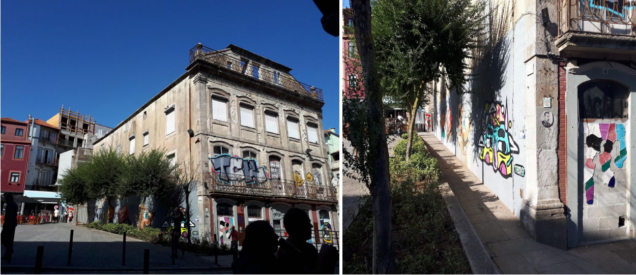
Figure 7. Facades and graffiti in Praça dos Poveiros , Porto.
