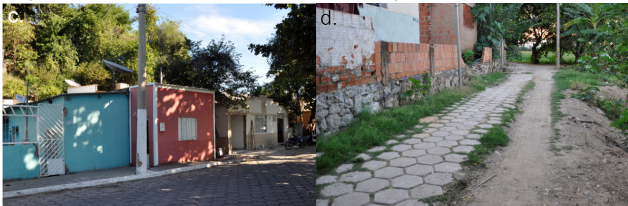
Figura 8. Calçadas estreitas e precárias (c) e via pública com largura incompatível com o trânsito (d).
