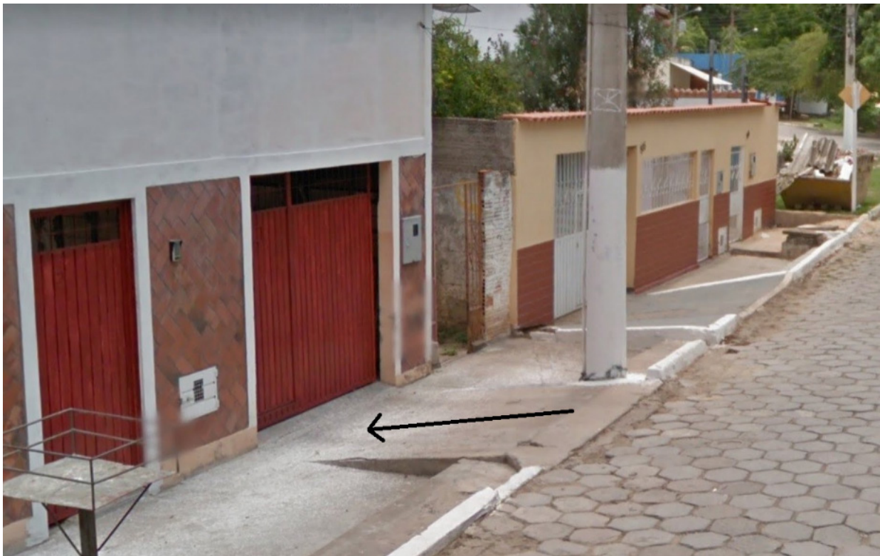
Figura 10. Edificações na Rua Domingos Sahib, abaixo do nível da via.
