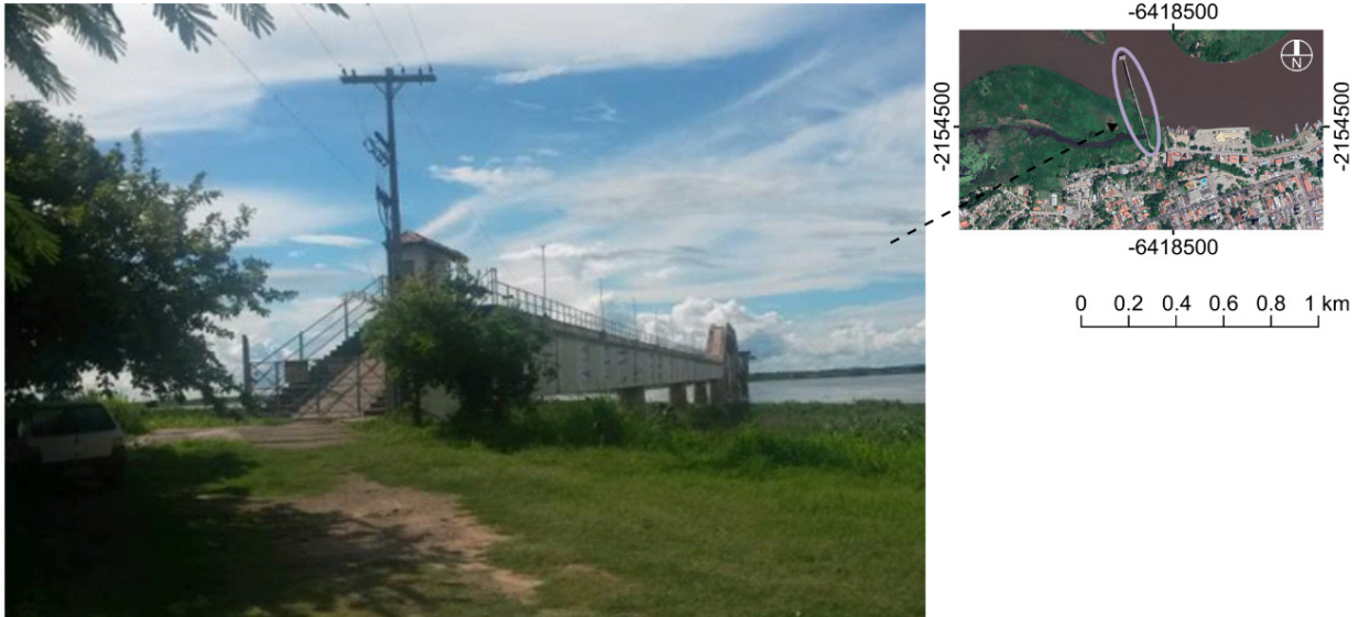
Figura 4. Captação de água do rio Paraguai em Corumbá, MS.
