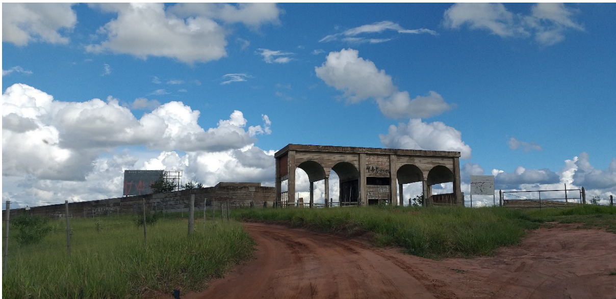
Figura 14. Portaria abandonada em área de preservação ambiental.
