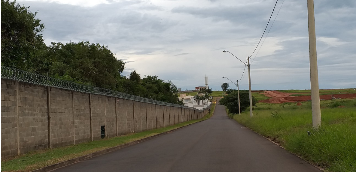
Figura 13. Viário ladeado por muros. À direita, mais um “condomínio” em obras.
