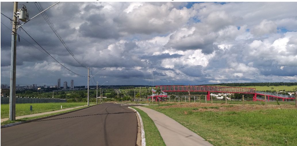
Figura 12. Passarela recém-construída sobre a rodovia Eng. João Batista Cabral. Ainda assim, os funcionários do "condomínio" percorrem 1,5 km (de um caminho vazio e sem sombreamento) até o ponto de ônibus mais próximo.
