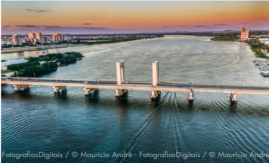
Figura 3. Ponte Presidente Dutra – Ligação Juazeiro (BA) e Petrolina (PE)
