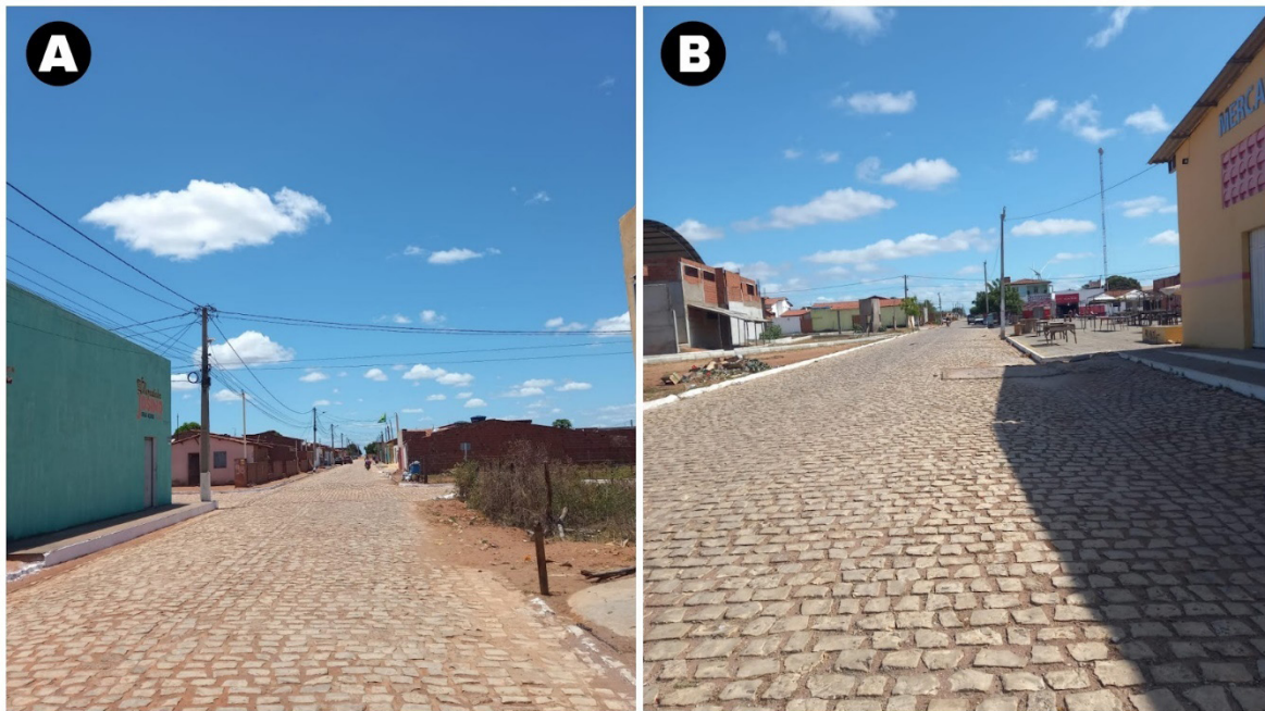
Figura 4: trechos de ruas pavimentadas e sem arborização na Vila Brasília, Serra do Mel, RN, (A) Avenida das Nações; (B) Rua do Própolis.
