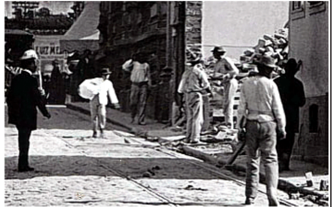
Figura 2 – Demolição de prédios antigos para alargamento da rua Líbero Badaró em São Paulo, em 1912
