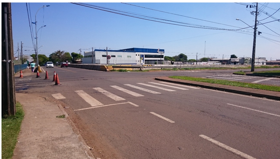
Figura 3: viaduto do bairro Conjunto Habitacional Requião, Maringá, PR.
