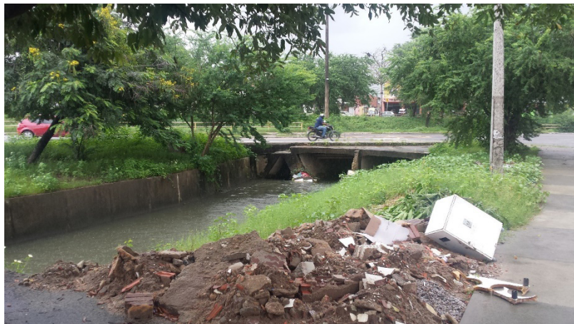
Figura 4: Margem direita do canal da Av. G.
