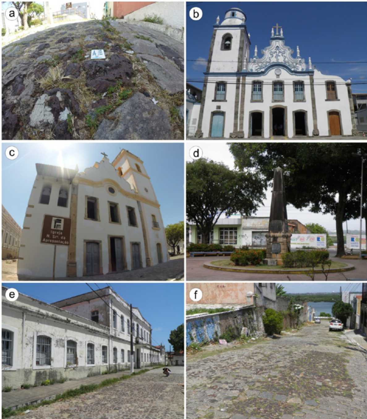
Figura 4 - Exemplares da geodiversidade encontradas em diferentes monumentos no Centro Histórico de Natal, no Bairro da Cidade Alta, com destaque para (a) fragmentos de arenitos ferruginosos na Rua Voluntário da Pátria; (b) Igreja Santo Antônio com colunas e cercaduras feitas de arenito calcífero; (c) Igreja Nossa Senhora da Apresentação com colunas e cercaduras também construídas em arenito calcífero; (d) Coluna dos Mártires, na Praça André de Albuquerque, construída em granito equigranular proveniente de Macaíba; (e) Arenitos ferruginosos compondo parte da Rua Cel. Lins Caldas, ao lado da Casa do Estudante; (f) parte da Rua Quintino Bocaiúva com fragmentos de arenito ferruginoso; (g) Pedra do Rosário formada por arenito ferruginoso encontrado na base da Coluna que sustenta a estátua de Nossa Senhora da Apresentação; (h) Travessa Pax com seus paralelepípedos formados por arenitos ferruginosos; (i) Monumento em homenagem ao 1o centenário da Independência do Brasil formado por granito equigranular; (j) Antiga sede do IPHAN com base da janela construída com arenito calcífero; (k) Antigo Pelourinho construído em arenito calcífero; (l) Monumento em homenagem ao Padre João Marinha construído em granito equigranular proveniente de Macaíba.
