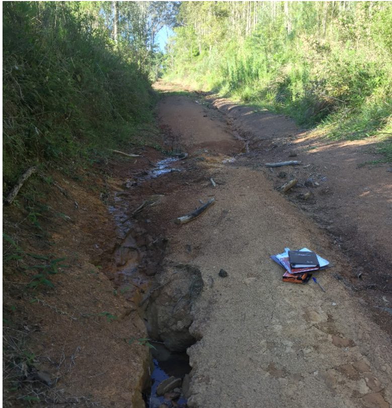
Figura 1. Abertura de estradas na vertente para transito de máquinas e retirada da madeira.
